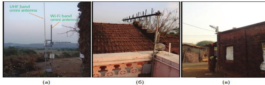
Рис. 3. Фотографії деяких UHF-CPE: а) Дхектан-2 UHF-CPE встановлене на вершині пагорбу без будинків навколо; б) та в) UHF-CPE зазвичай встановлюється на висоті 4–6 м.
