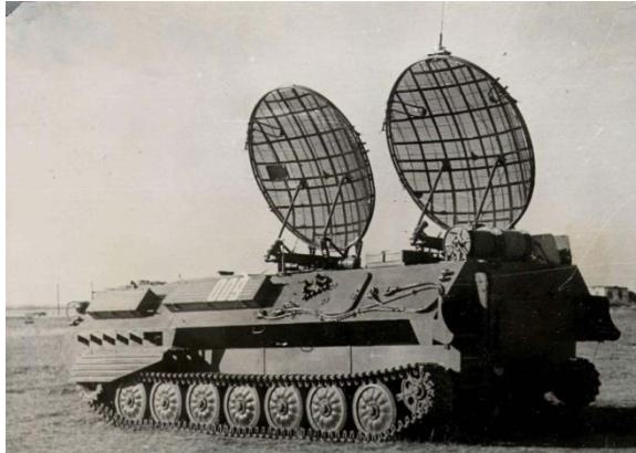
Рис. 1. Тропосферна станція Р-412Б - мобільний варіант на броньованій базі
